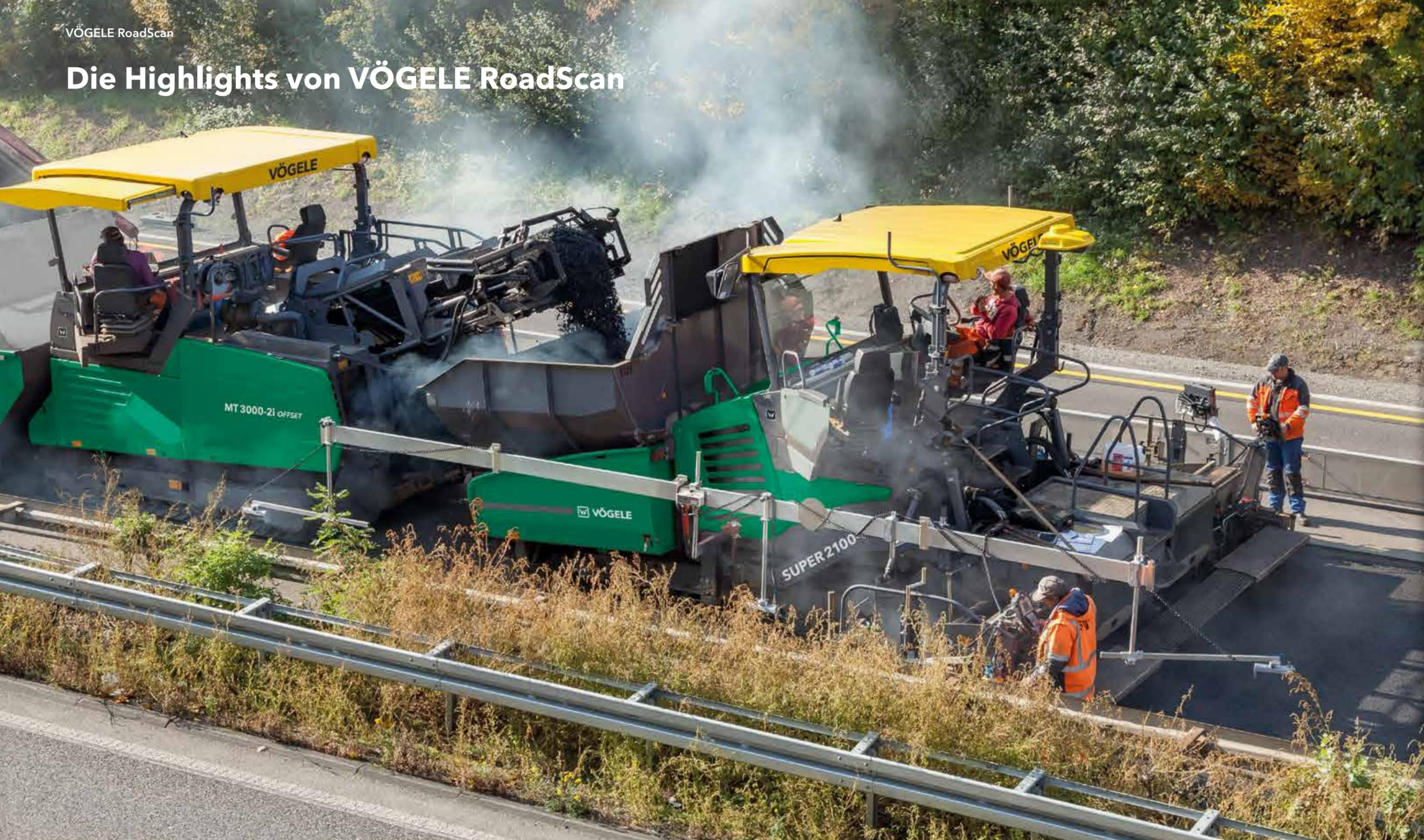
**Flächendeckende Temperaturmessung** über die gesamte Arbeitsbreite bis zu 10,00 Metern
