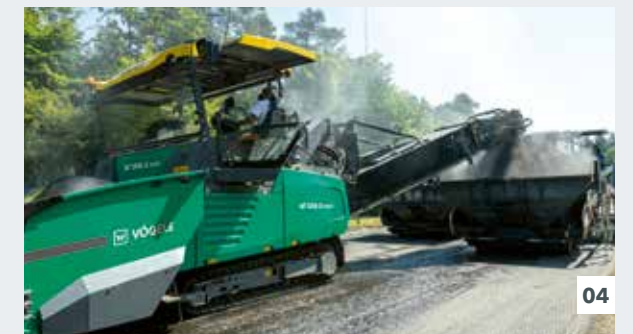
Машинисту перегружателя открывается абсолютно свободный, ничем не заслоненный вид на самосвалы для подвоза смеси и на укладчик SUPER 2100-3i IP.
