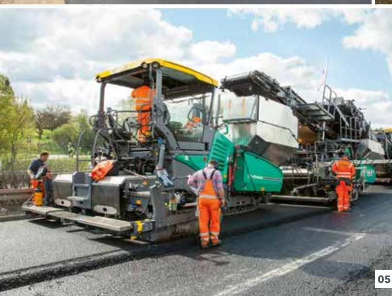
01 Ремонт федеральной дороги с применением бесшовной технологии, радиусы поворотов – менее 200 м.
