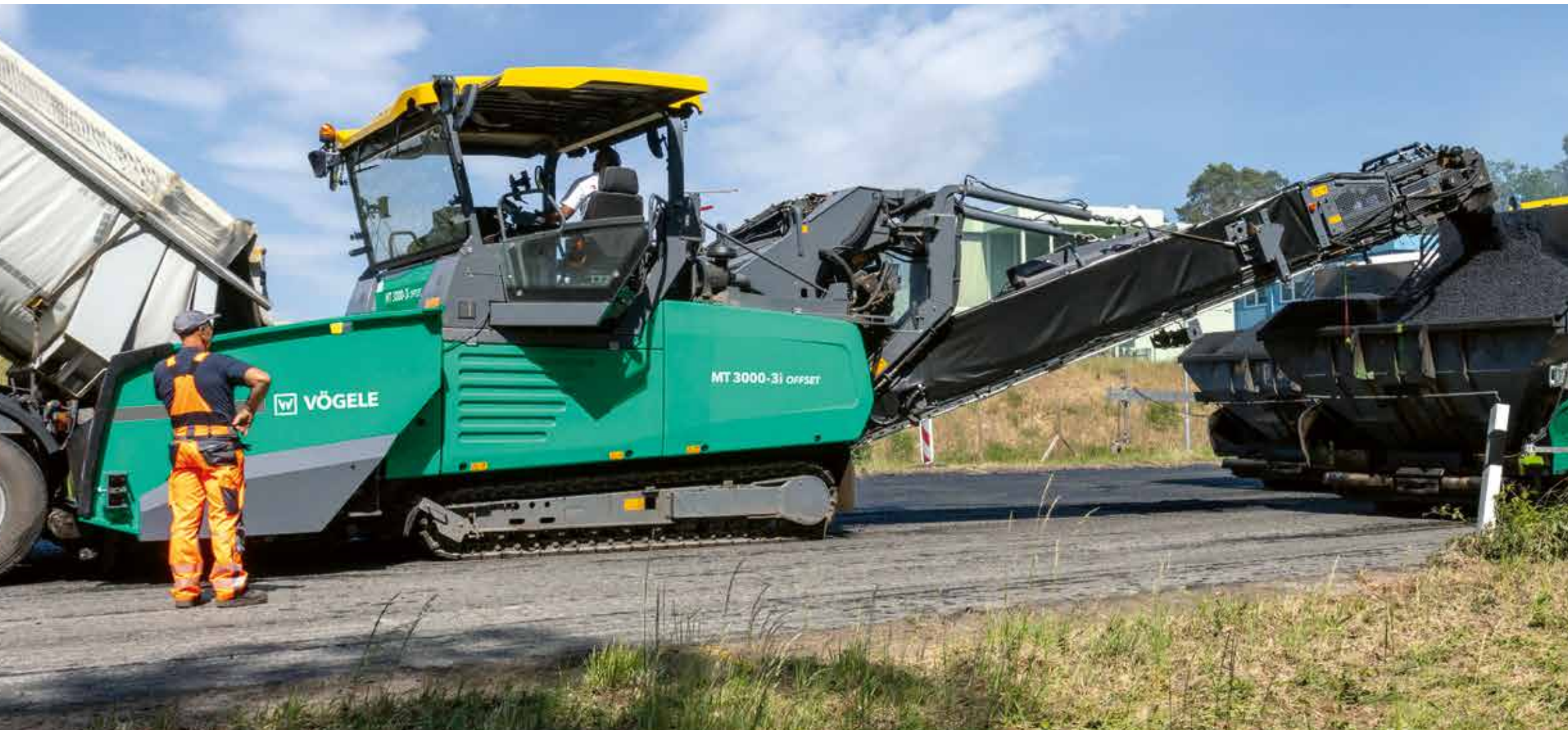
Через перегрузочный модуль укладчика для устройства слоя биндера смесь попадает в укладчик.
