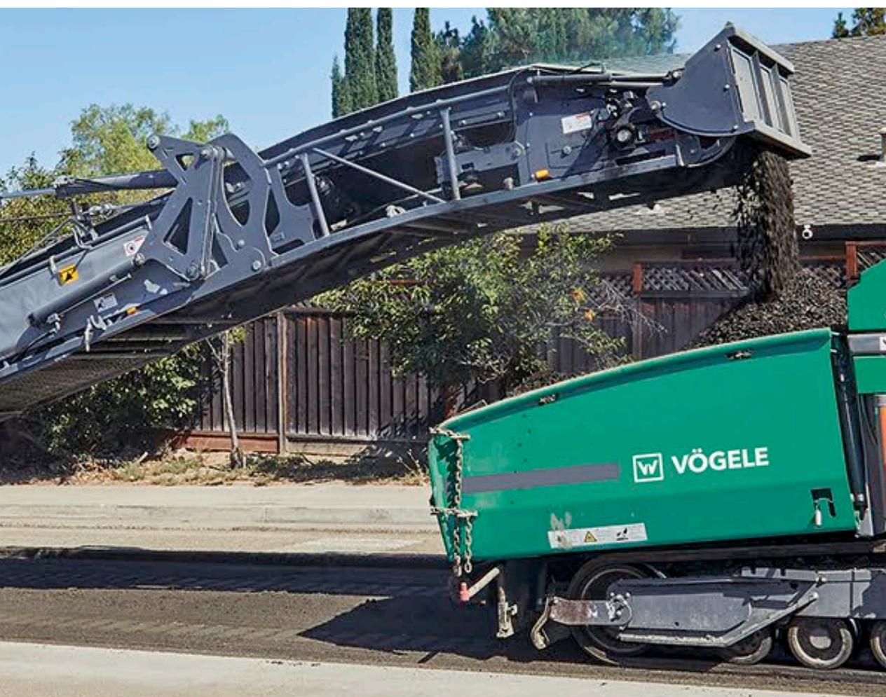
**01** La recicladora en frío rehabilita carreteras con una capacidad de mezcla de hasta 800 t/h.
