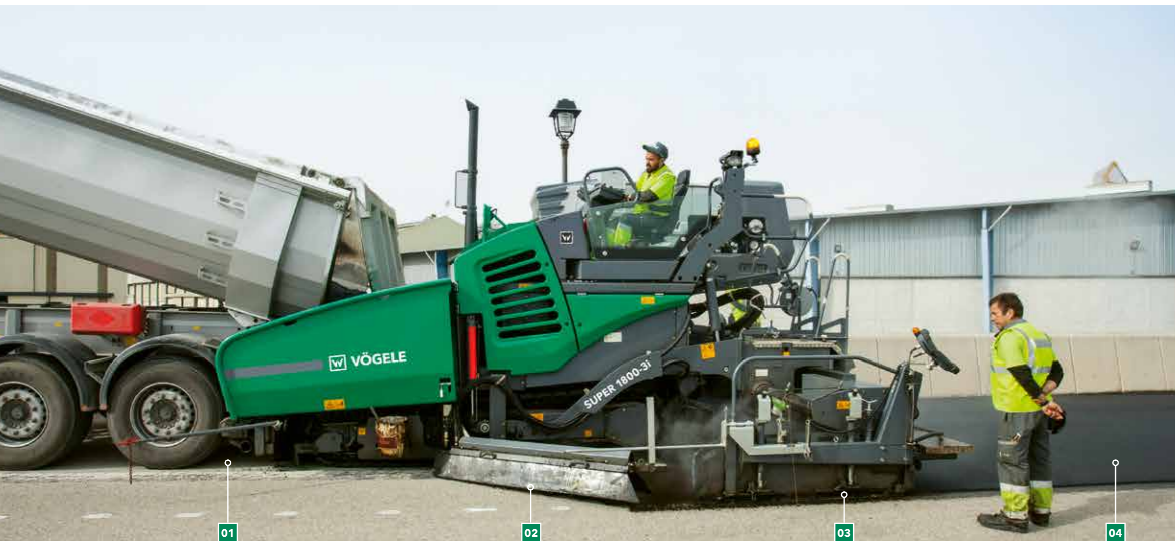
Auftragen der zwischen 70 und 80 °C heißen Bitumenemulsion durch den Sprühfertiger.
