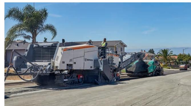
W 380 CRi con cinta de descarga, anchura de trabajo de 3,8 m y pavimentadora incluida
